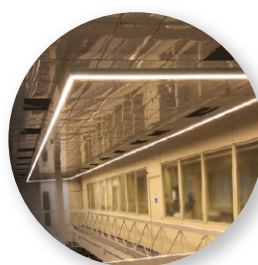
Estruturas de grande dimensão
